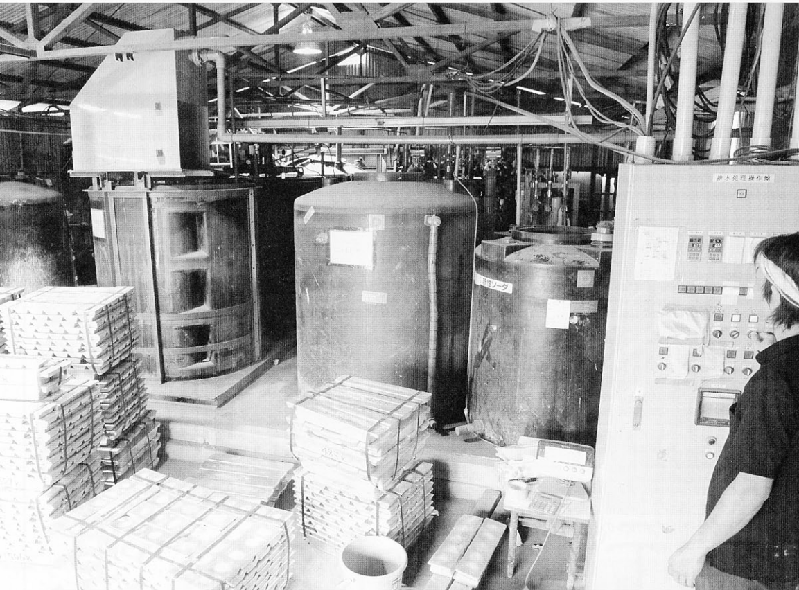
▲排水を浄化して流す浄水施設。同社が自前で設置した
